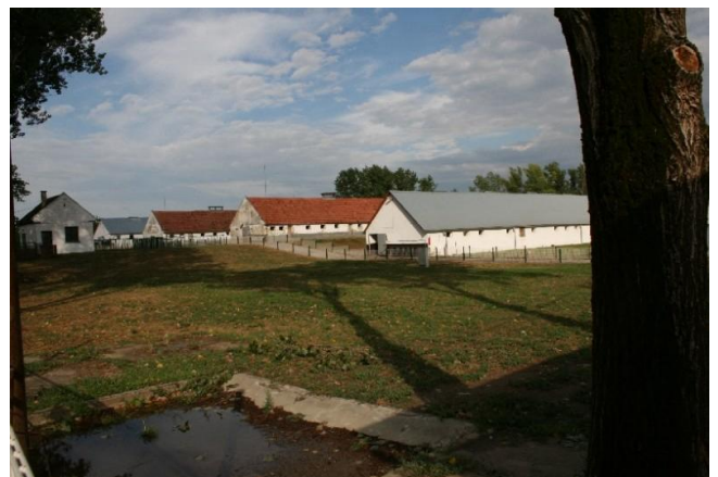
Abb. 2: Für die Sanierung der ehemaligen LPGen fehlt es in den meisten Fällen an Kapital
