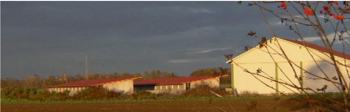
Abb. 5: Label 1: Blick auf 2 Pigports mit den Ausläufen (1.000 Mastplätze)
