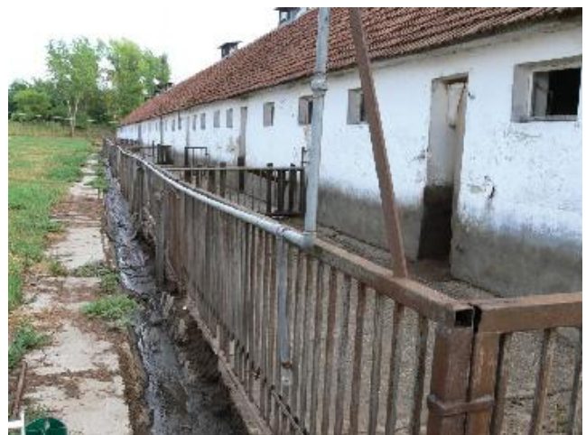
Abb.2: Zahlreiche Stallanlagen mussten komplett erneuert werden, da selbst die Bauhüllen in schlechtem Zustand waren.
