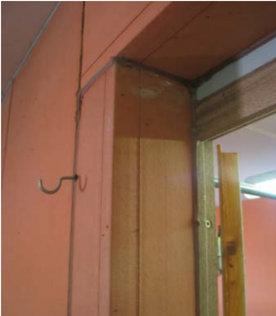
Abbildung 3: Aufbau Tonelemente an einem Türzarge Abbildung 4: Lichtschächte eingebracht in Porendecke
