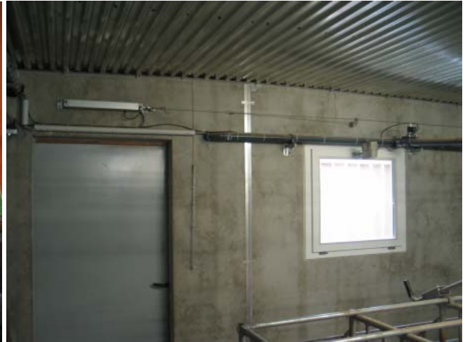
Abbildung 8: zentraler Strommagnet (links über Türe) und Fenster mit Gegengewicht (Stein) zum Öffnen bei Stromausfall
