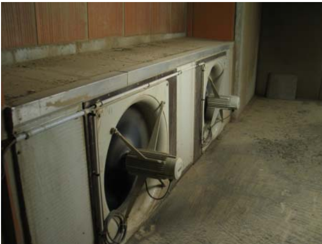
Abbildung 1: zentrale Unterflurabsaugung
