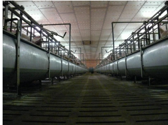
Abb.8: Wartestall mit Porendecke - Zuluft über gekühlten Dachraum
