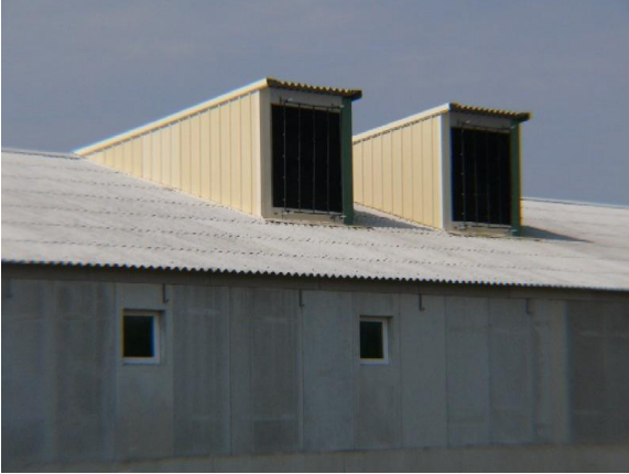
Abb.1: Flächenkühler im Dacheinbau mit Zuführung in den isolierten Dachraum
