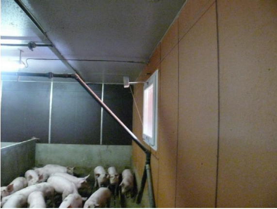
Abb. 23 & 24: bei Stromausfall öffnen sich die gewichtsbelasteten Fenster automatisch durch Abschaltung des Elektromagnetes
