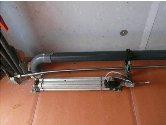
Abb. 25 & 26: die Öffnung der Fenster erfolgt bei Stromausfall automatisch, entweder über Pneumatikzylinder oder Magnetventile
