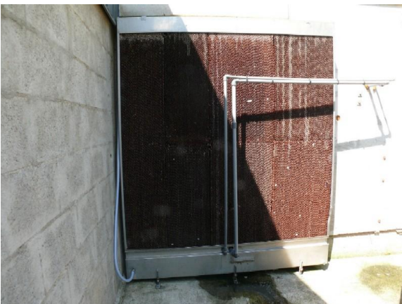
Abb.3: Flächenkühlereinbau im Zentralgang
