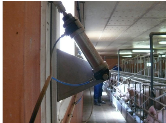
Abb. 25 & 26: die Öffnung der Fenster erfolgt bei Stromausfall automatisch, entweder über Pneumatikzylinder oder Magnetventile
