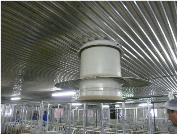
Abb.13: Oberflurabsaugung für 60 % der Sommerluft
