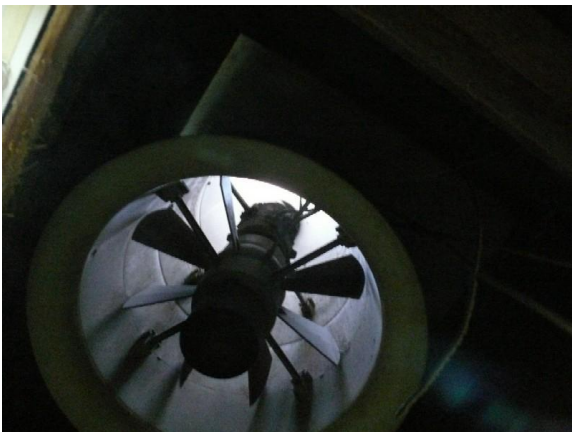
Abb. 21: Ablüfter mit eingebauten Lüfterdrosselklappen
