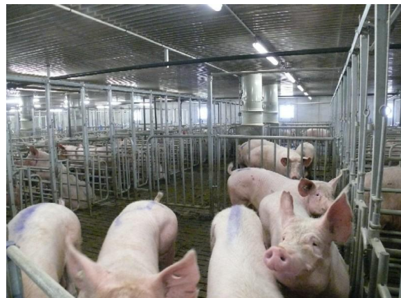
Abb.6: Warteabteil mit diffuser Aludecke und Unterflurabsaugung
