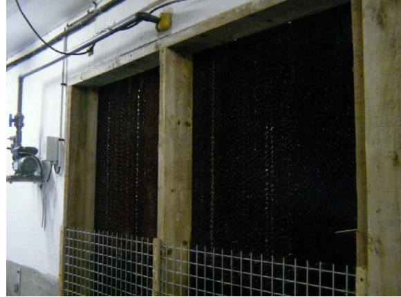
Abb.2: Einbau des Flächenkühlers im Zentralgang
