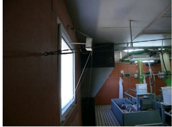
Abb. 23 & 24: bei Stromausfall öffnen sich die gewichtsbelasteten Fenster automatisch durch Abschaltung des Elektromagnetes
