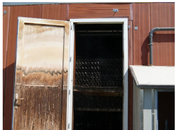
Abb.18: Blick in den Abluftwäscher mit Kunststoffwaben
