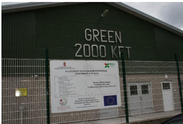
Abb. 1: Die Anlage „Green 2000 KFT“ ist mit einem 3 m hohen Zaun versehen
