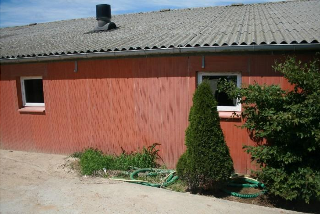
Abb. 2: Die meisten Ställe werden aus großvolumigen (75x250), sehr wetterfesten Tonziegelfertigteilen aus Toulouse gebaut.
